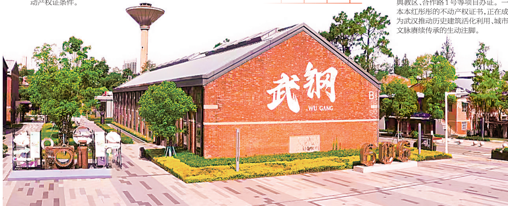
武钢云谷·606产业园将老厂房改造现代化园区,吸引懂车帝汽车商城等业态入驻。
