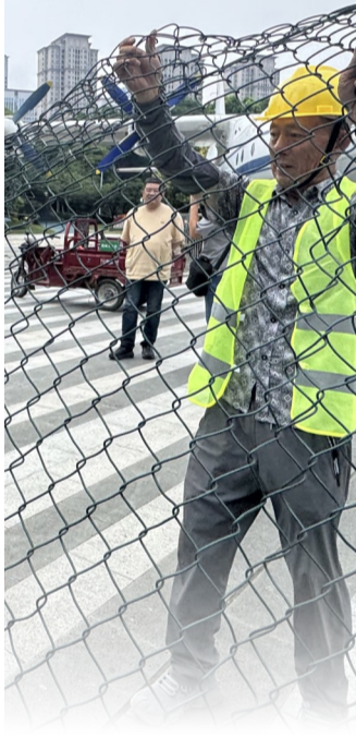
6月3日下午,工人拆除王家墩公园最后一段菱形网墙。 长江日报记者陶常宁 摄
