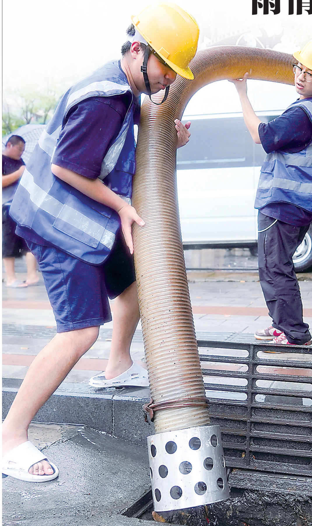
新华路马场路口,排水工作人员占永杰(左)和徐佳欣抬起进水管。
