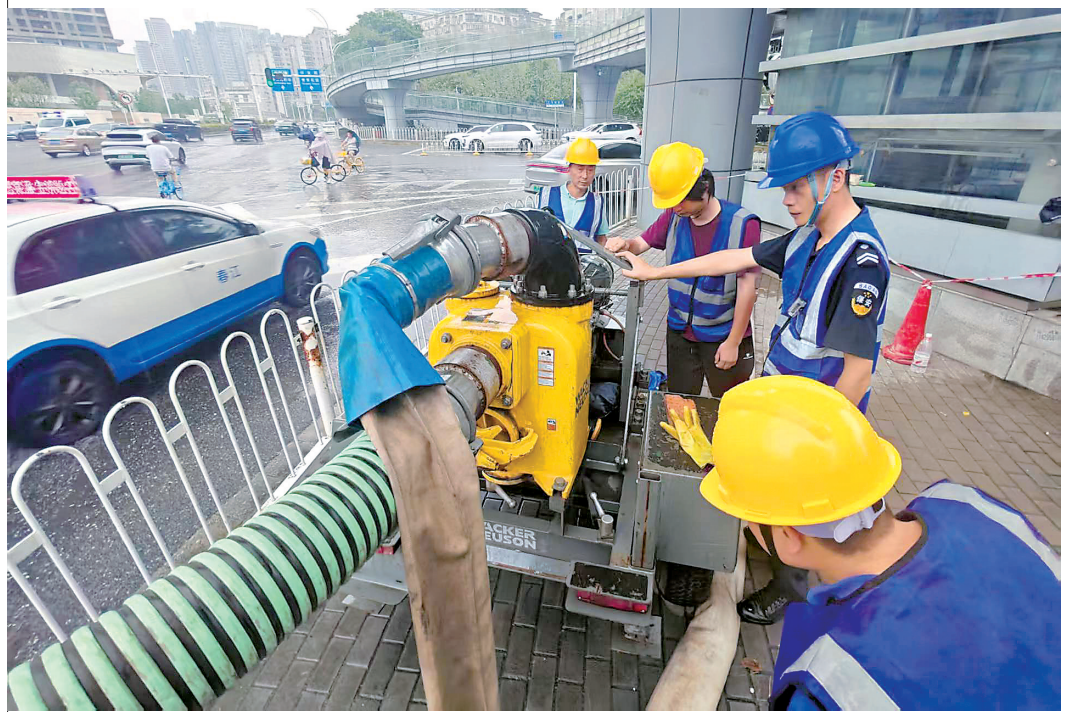
马场路与唐家墩路交会处人行天桥下,江汉区排水队工作人员检查抽排设备。
