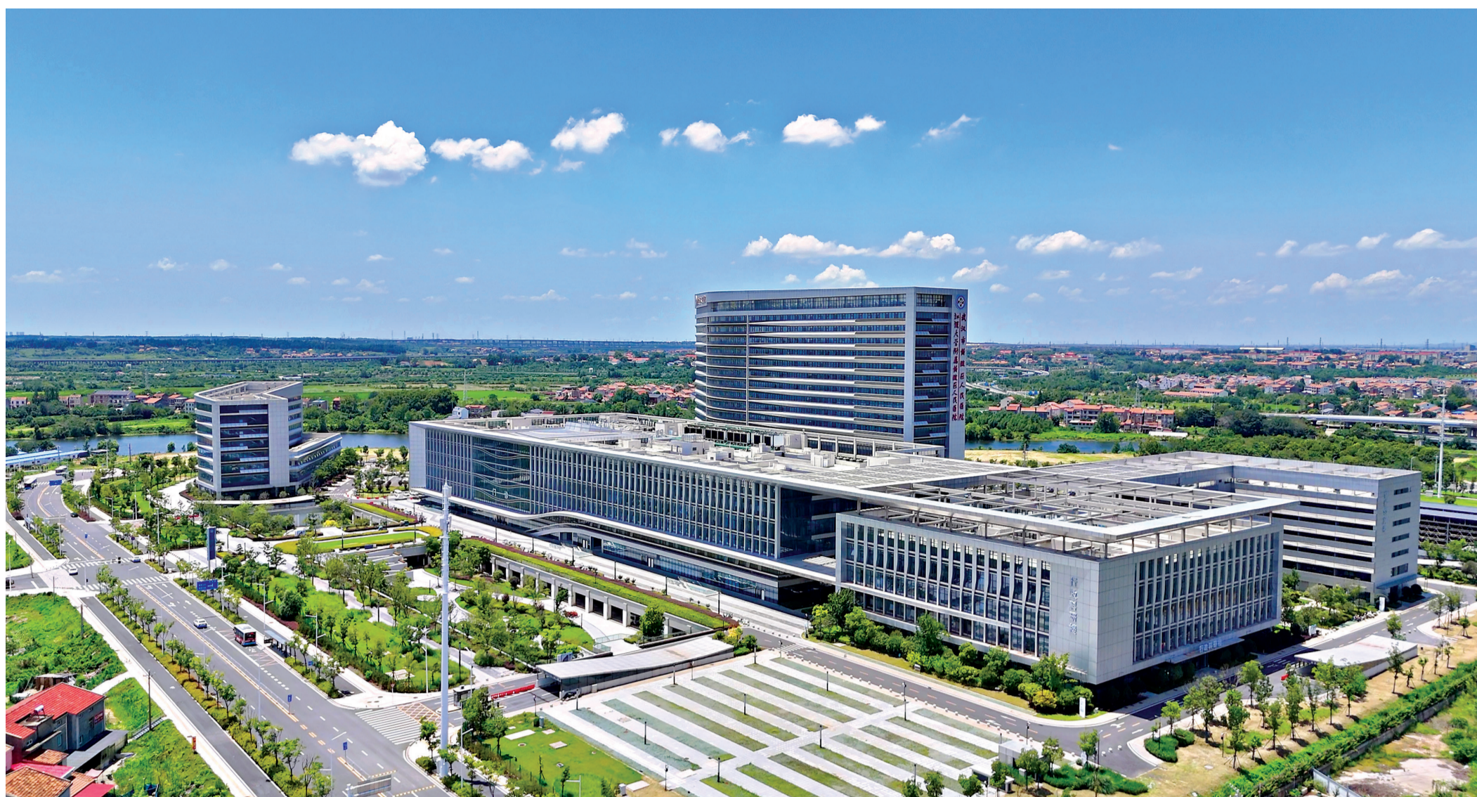
黄浦区人民医院航拍图。
