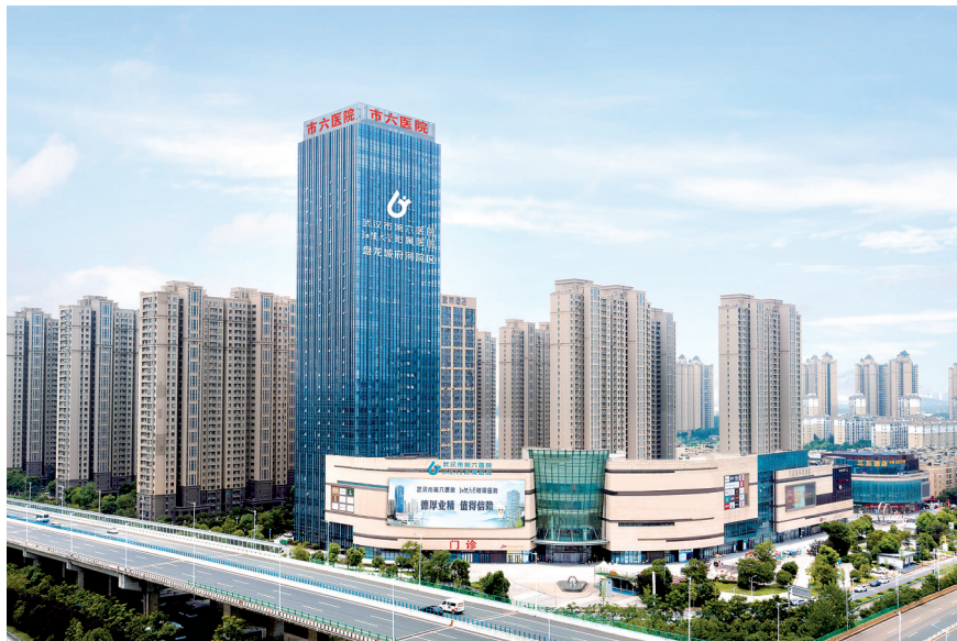
市六医院盘龙城府河院区创新“地上医疗+地下健康管理”立体更新模式,打造全省首例楼宇改三级综合医院。
