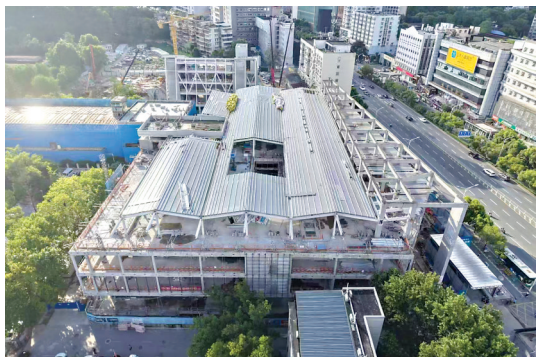
广埠屯·锦鲤施工现场。
