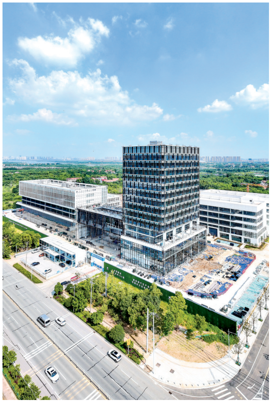
武汉航空新材料产业园研发楼已封顶。
