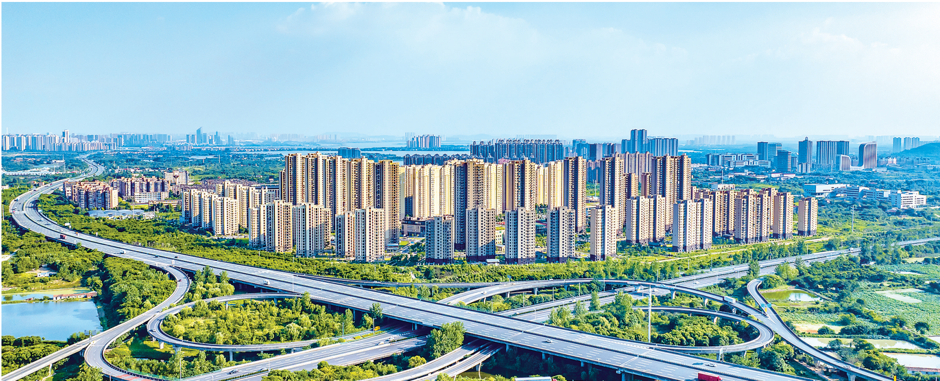
武汉市首批城市更新城中村改造典型案例之一——中法半岛小镇项目。
