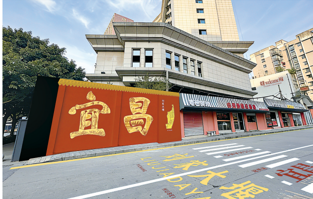
宜昌刘家大堰老旧小区改造项目。
