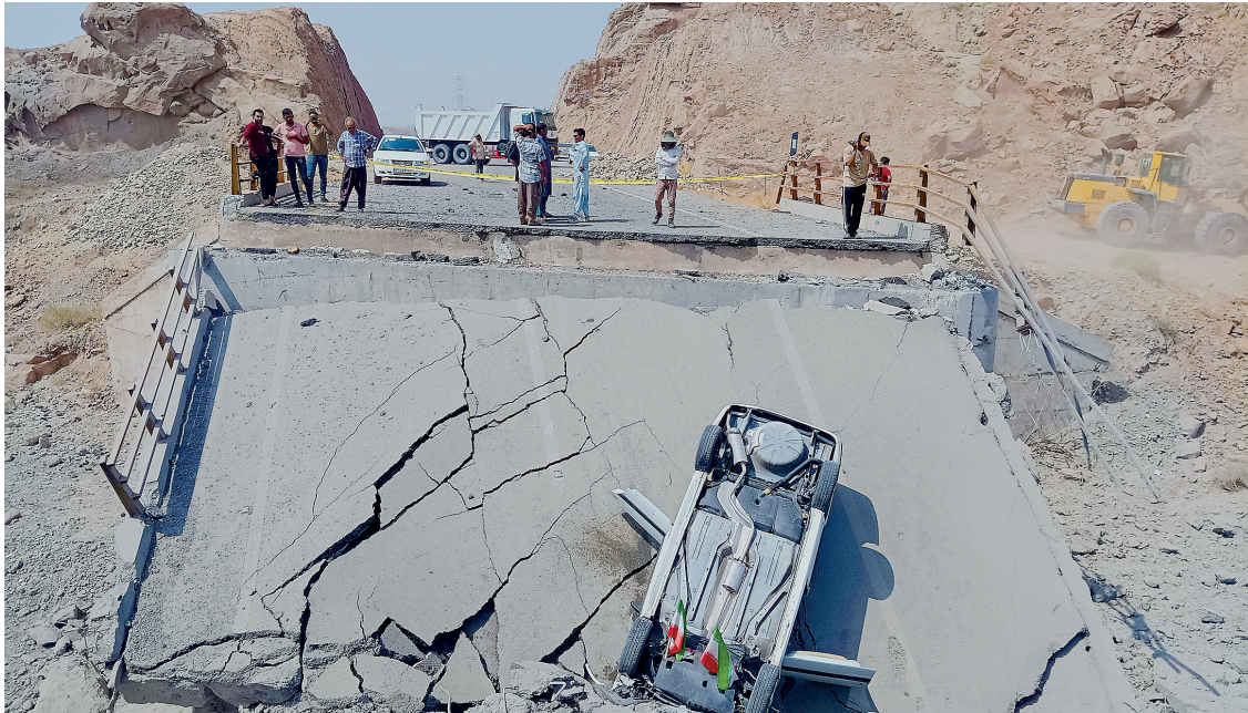
7月18日，在伊朗霍尔木兹甘省，人们站在遭空袭损毁的桥梁上查看一辆翻倒的车辆。
