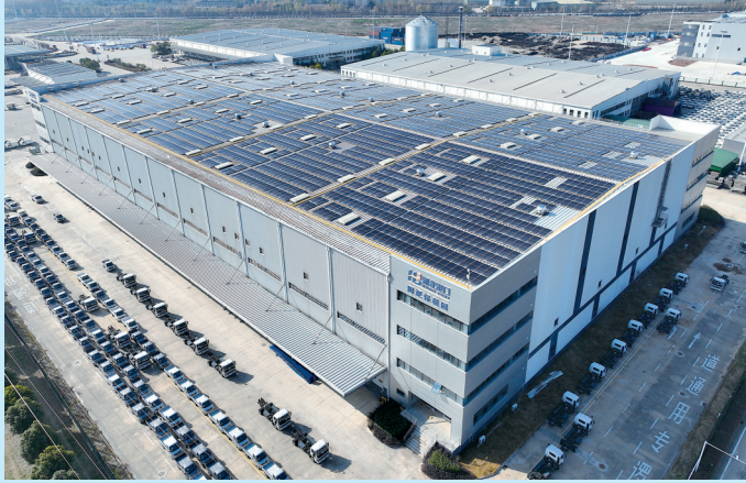
新港空港综保区。
