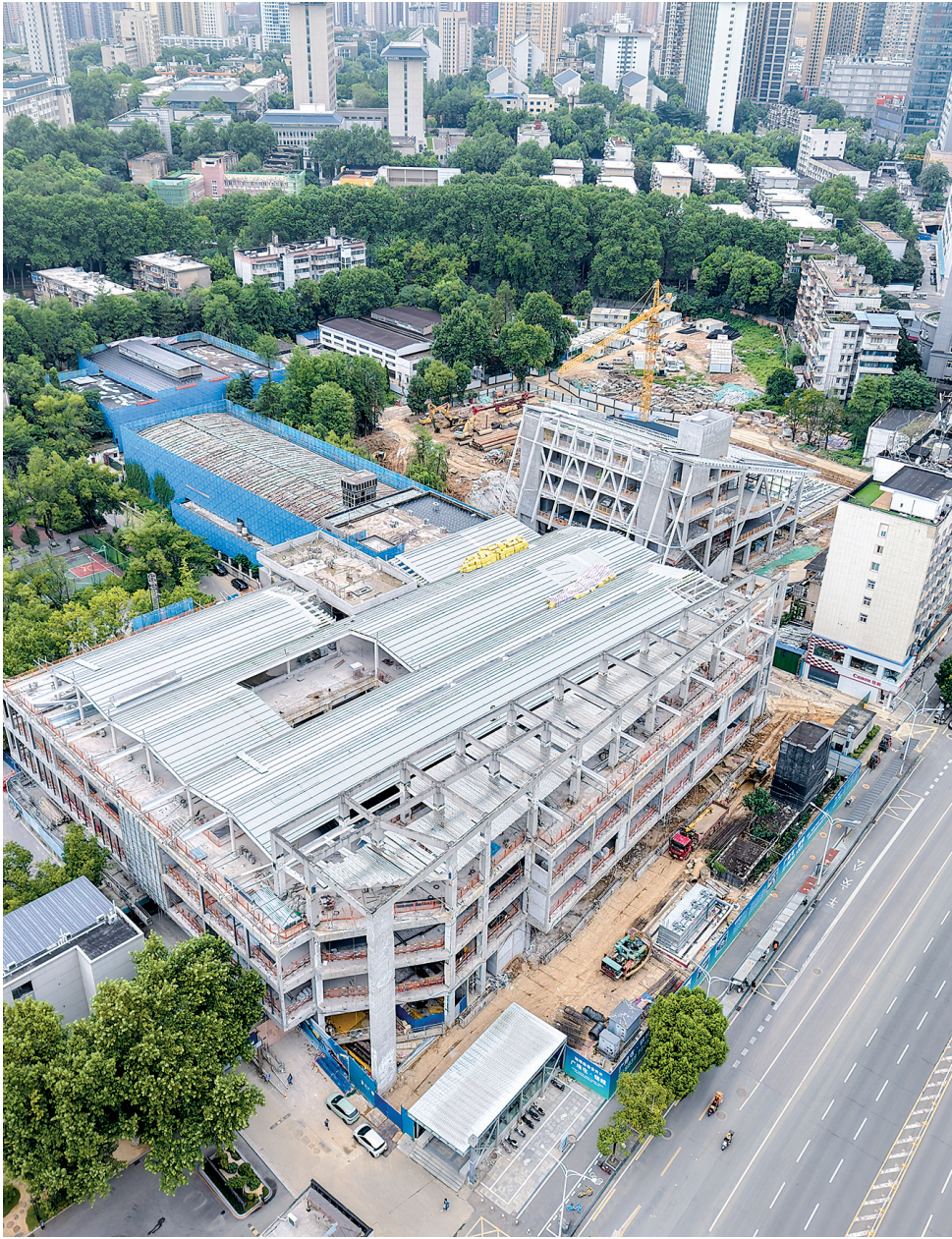
建设中的广埠屯·锦鲤。
