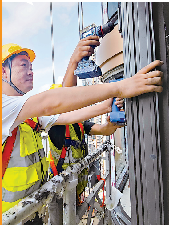
吴科(左)和同事在百米高空安装建筑玻璃窗。 长江日报记者宋磊 摄
