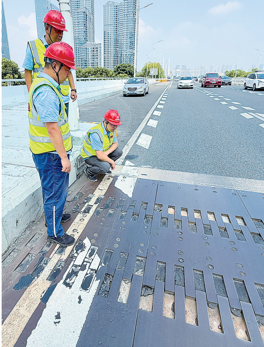
运维队员检查桥体伸缩缝。 长江日报记者袁璇 摄
