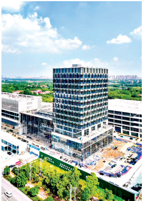
武汉航空新材料产业园研发楼封顶。
