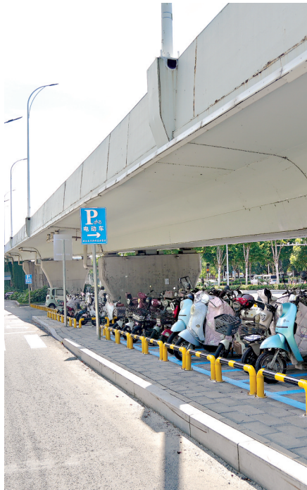
桥下空间变成非机动车停车场,避免车辆日晒雨淋。通讯员供图
