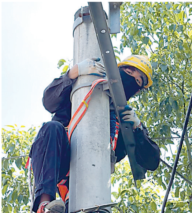
电力工陈鼎琪正在高空检修铁路供电设备。 长江日报记者高文举 摄
