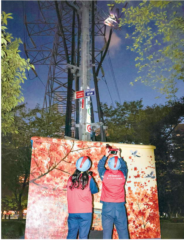
涂睿(右)和陈梓豫正在给铁塔上电缆终端的多个重要部位测温。 长江日报记者刘克取 摄
