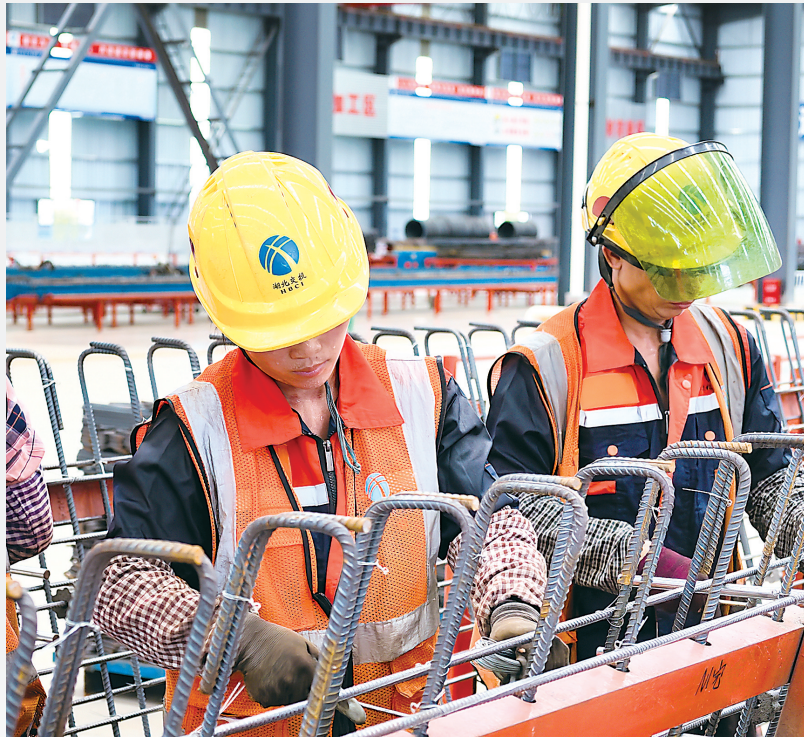
黄小高速改扩建项目综合场站内,工人们在绑扎预制梁钢筋骨架。
