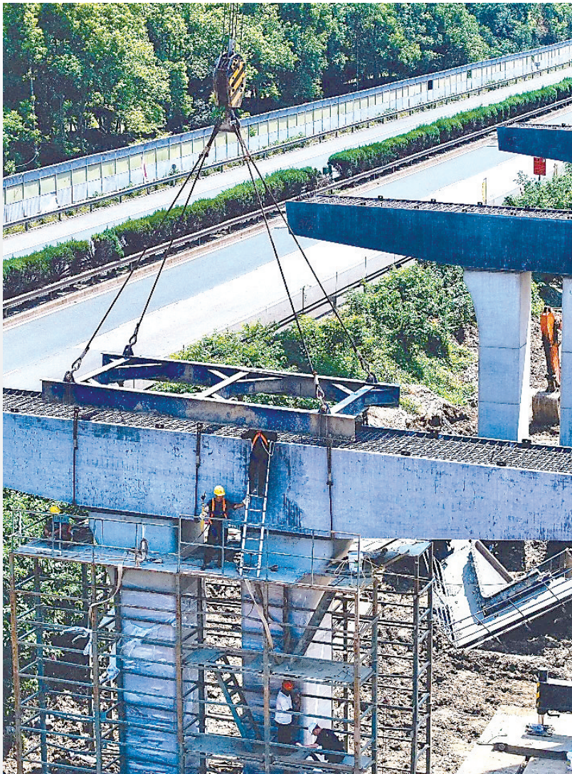
汉宜高速改扩建项目施工现场,大型机械在吊装“楚天梁”。
