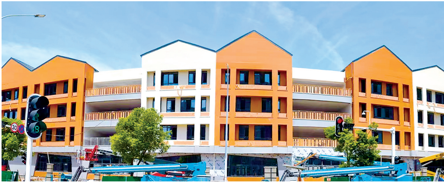
奋进智能钢模现浇的水泥墙体提升建筑的保温与防潮性能。
