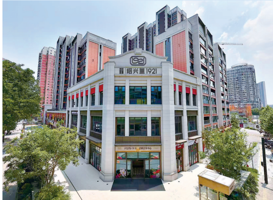
工行武汉分行积极服务城市更新，助力绍兴片改造项目。
