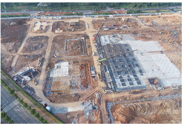
先进封装产业化基地项目。
