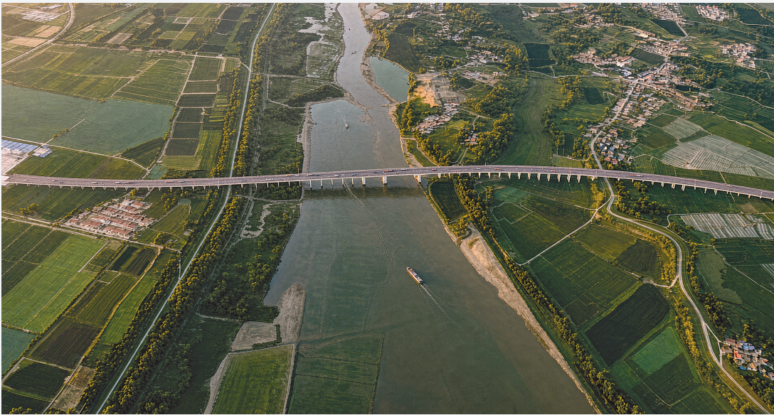
G347国道举水河大桥航拍。
